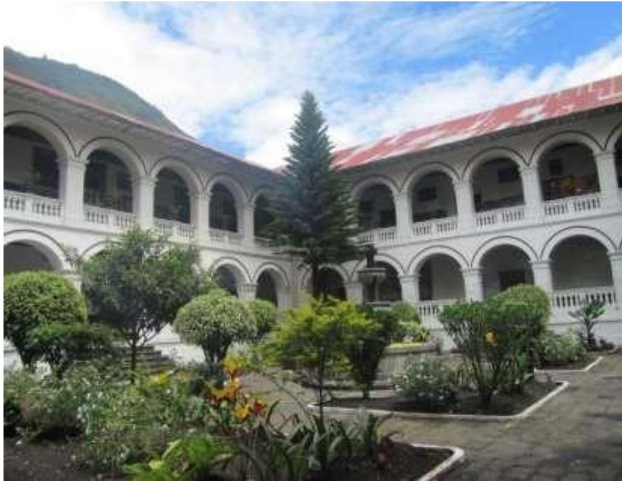
Foto 2.13 Convento de la Basílica Menor de la Virgen del Rosario de Baños de Agua Santa. En su interior existen obras de arte (pinturas) referentes a las erupciones históricas del volcán Tungurahua.
