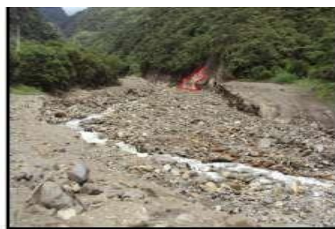
Piedra ubicada a un costado del río, donde se presume que se desvió el caudal el día del aluvión, origina que éste ingrese a la zona habitada.
