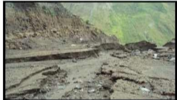
Parte de la erosión que produce por el descenso del Lahar
