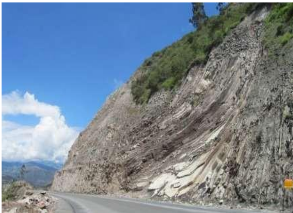
Foto2.10 Nueva vía a Riobamba, frente a la quebrada Ingapirca del flanco Occidental del volcán Tungurahua. Se observa otro afloramiento de avalancha de escombros, el cual es un material muy inestable y susceptible a provocar movimientos en masa.
